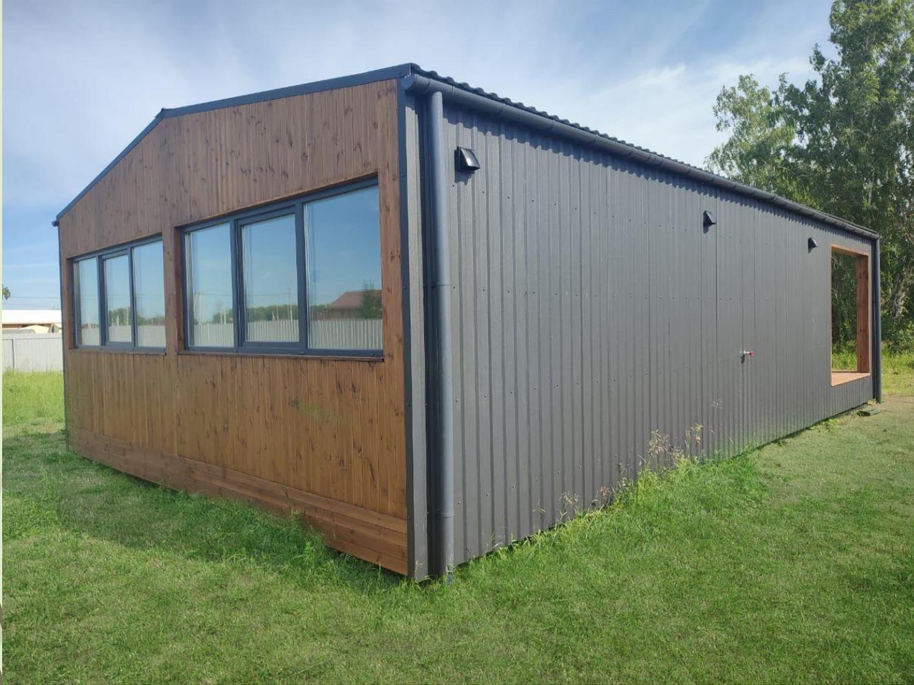
1. Наружные стены – 230 мм, перегородки – 160 мм. Конструктив стен - утеплитель мин вата толщиной -150мм, ветрозащита - (гидрофильная (полиуретановая) мембрана) со стороны фасада. Внутренняя пароизоляция - пищевой полиэтилен 200мкм. Наружная отделка планкен вертикальный с торцов (цвет палисандр) и профлист в боковой части (цвет графит), внутренняя отделка – вагонка вертикальная белого цвета.
