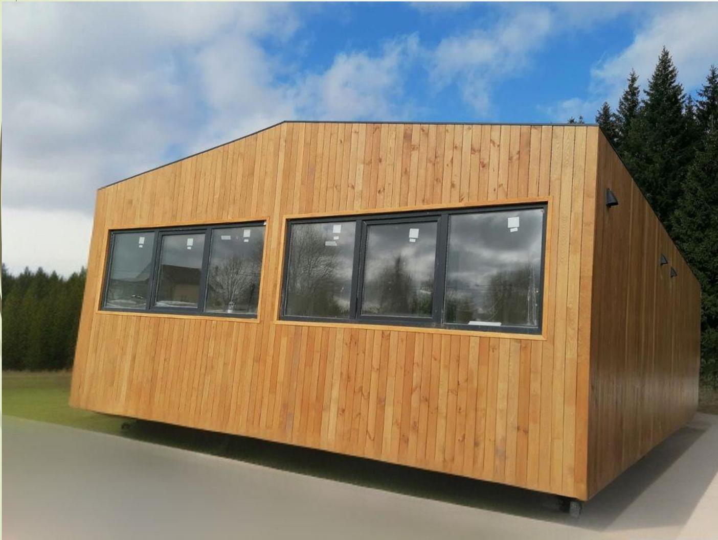
1. Наружные стены – 375 мм, перегородки – 160 мм. Конструктив стен - утеплитель мин вата толщиной -150мм, ветрозащита - (гидрофильная (полиуретановая) мембрана) со стороны фасада. Внутренняя пароизоляция - пищевой полиэтилен 200мкм. Наружная отделка планкен вертикальный, цвет палисандр, внутренняя – вагонка вертикальная белого цвета. Воздушная прослойка - 145 мм для монтажа скрытой водосточной системы
